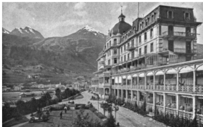
Il Sanatorio Valbella nel 1915, l'edificio ispirò a Thomas Mann l'aspetto esteriore del Berghof del romanzo. Fonte: Dokumentationsbibliothek Davos.
