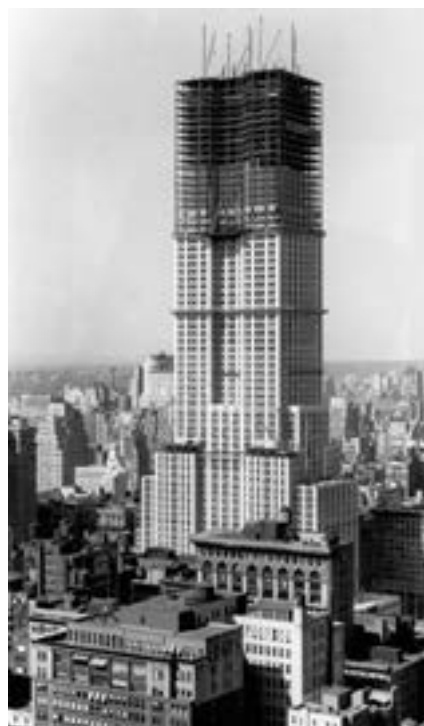
Il cantiere dell'Empire State Building, il grattacielo voluto da John Raskob. Fonte Bettmann/Corbis
